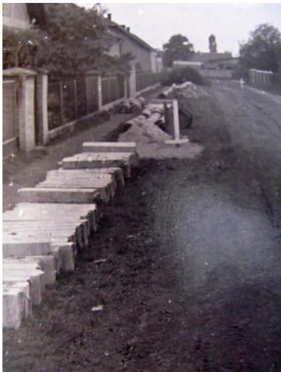
Foto č.1 – příprava na začátek výkopových prací, jaro 1962
