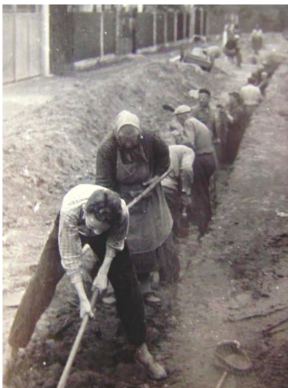
Díky občanům bydlících v této ulici se podařilo vybudovat kanalizaci.
