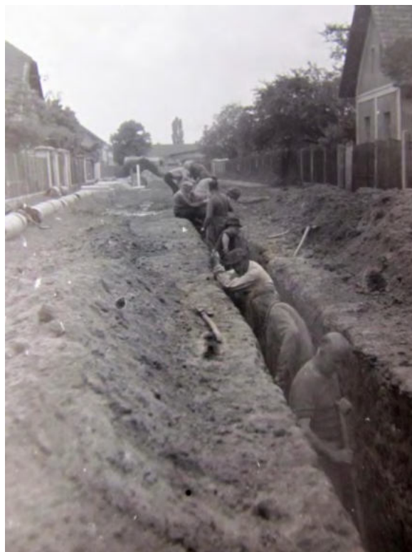
Foto č.3 – pohled na výkopové práce ve směru k hlavní silnici, kde v této části je hloubka výkopu až 218cm.
